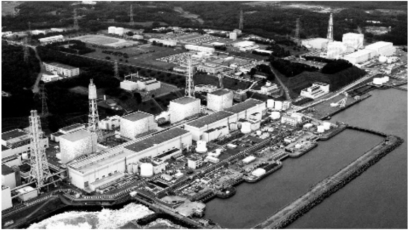
図7：福島第一原子力発電所
